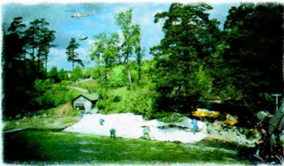
Utlagt strandskyddssystem och transport av styrlänsor med hjälp av helikopter.
