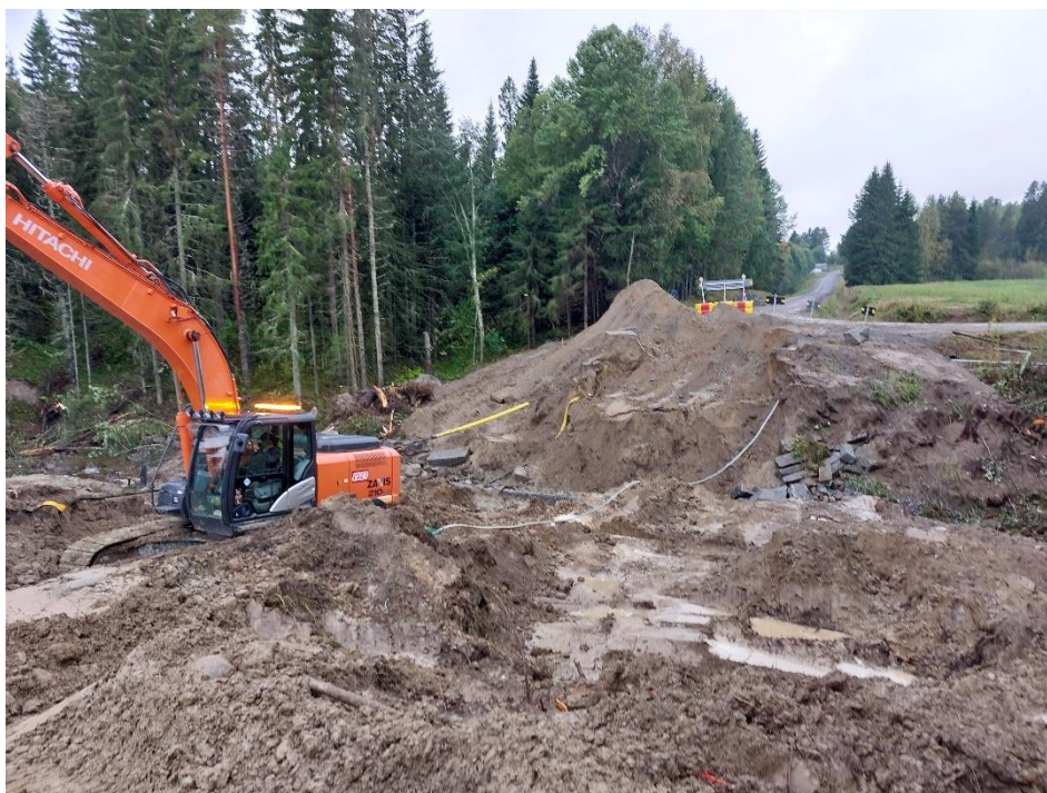
Väg 738, Judeby, under reparationsarbetet 20250916 Foto: Länsstyrelsen Västernorrland
