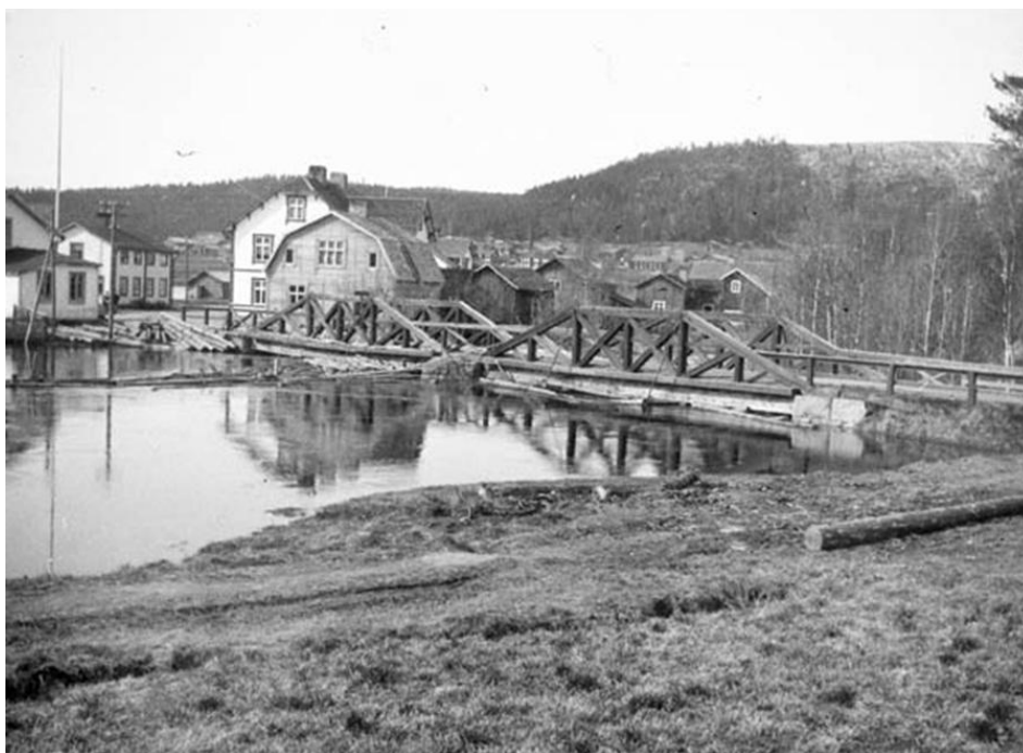
Gamla bron över Norra Anundsjöån i Kubbe 19260525. På fotot syns flera av de hus som drabbades av översvämningarna i september 2025. Fotot är taget två dagar efter att vårflodstoppen passerat 1926. Man kan tänka sig att stocken till höger i bild har hamnat där vid det maximala flödet. Foto: SMHI.
