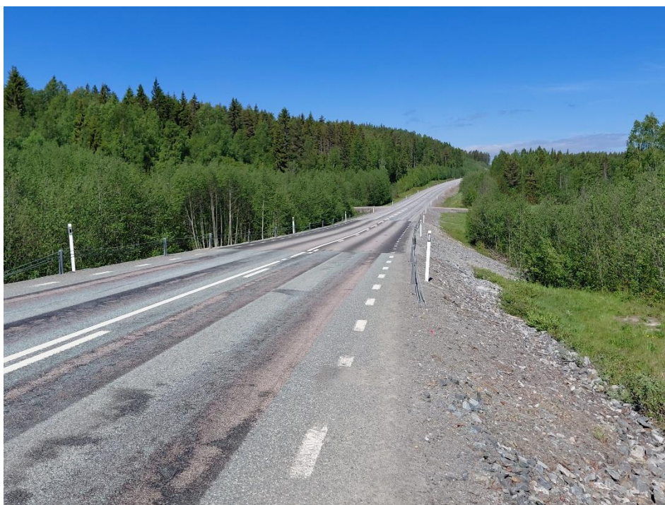
Riksväg 90 vid Kyrkdal efter återställning, 20260602. Foto: Länsstyrelsen Västernorrland
