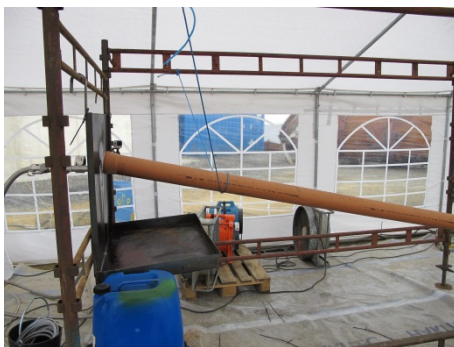
Figur 11. PVC-rör för dämpning av utsläpp.
