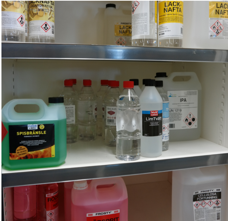
Exempel på förvaring av brandfarliga vätskor i skåp. Foto: MSB.
