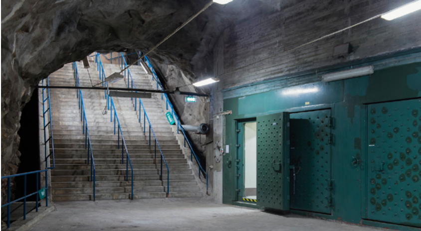
Ett antal skyddsrum i tätorter byggdes i berg för att klara kärnvapenhotet. Foto: MSB/Eva Dalin.
