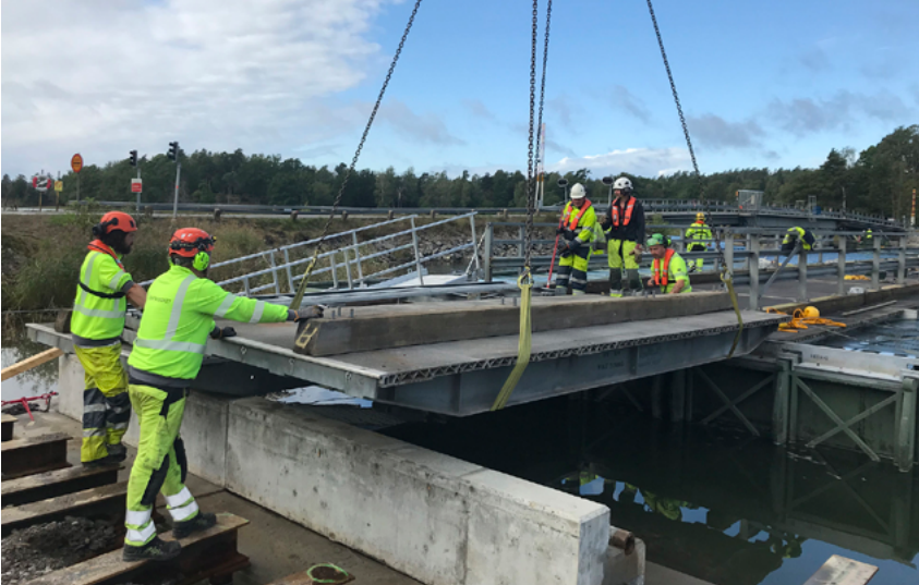
Trafikverket bygger en tillfällig bro som kan användas i krig. Foto: Trafikverket.
