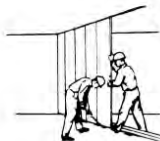
Montering av stående mellanväggselement. Anslutningsytorna bestryks med fogbruk. Här efter höjer en man elementet med hjälp av spettet och den andre pressar elementet mot det redan monterade väggpartiet. Elementet fixeras sedan tillfälligt med underkilning.
