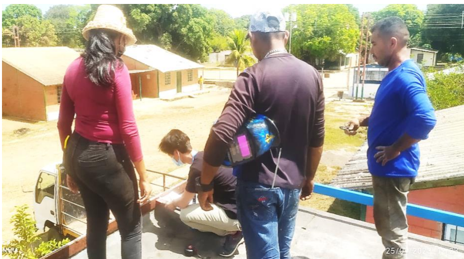
Byggingenjör Virginia Canales (sittandes på huk) är sekonderad av MSB till Unicef i Venezuela. Här genomför hon besiktning av ett hälsocenter i Los Pijiguaos, i Bolivarregionen, tillsammans med lokalt anställd personal som ansvarar för underhållet av byggnaderna. Foto: Andres Figueras, Unicef
