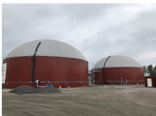
Figur 32. Rötkammare med membranöverdel. Foto: David Gårsjö.
