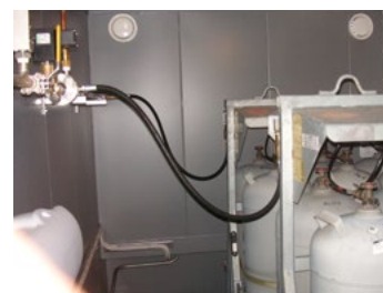
Figur 36. Exempel på slanginstallation.
