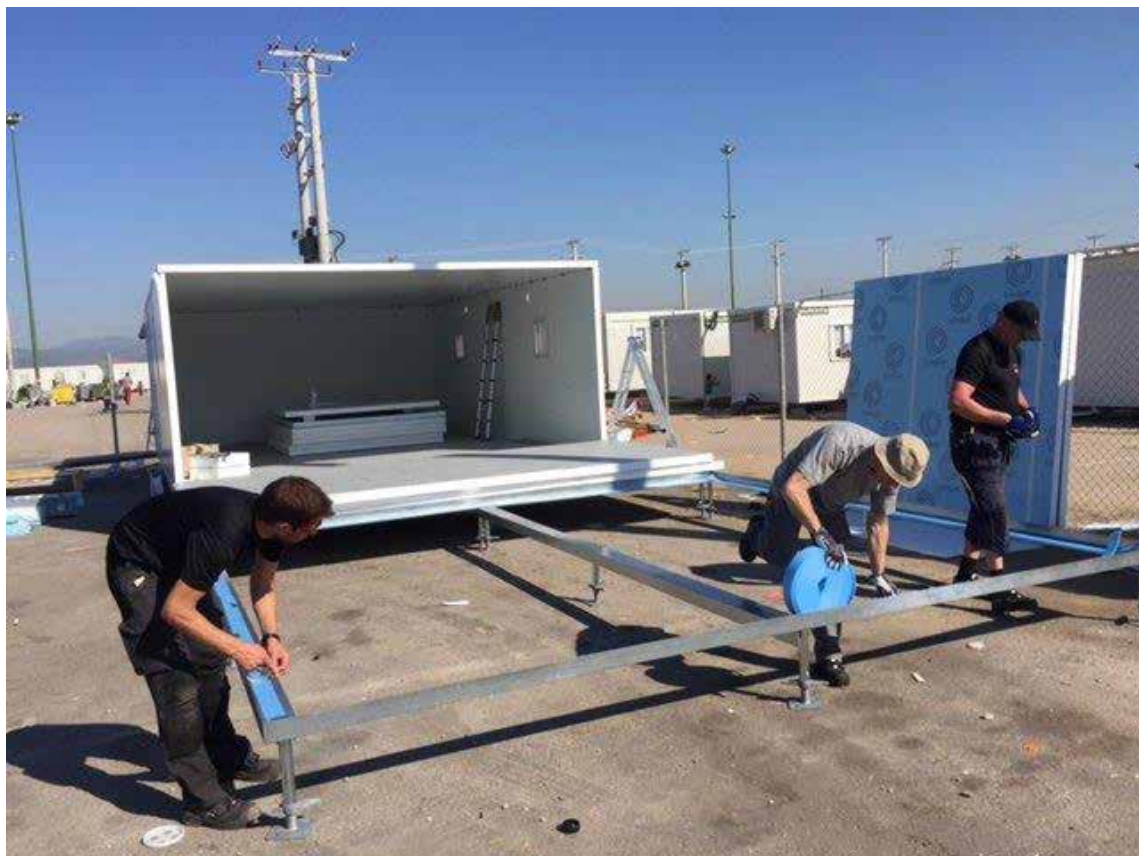
MSB:s insatspersonal bygger grunden för en av de lokaler som ska användas till sjukvårdsinrättning i Skaramangas, Grekland. Foto: Ulrika Eden, MSB
