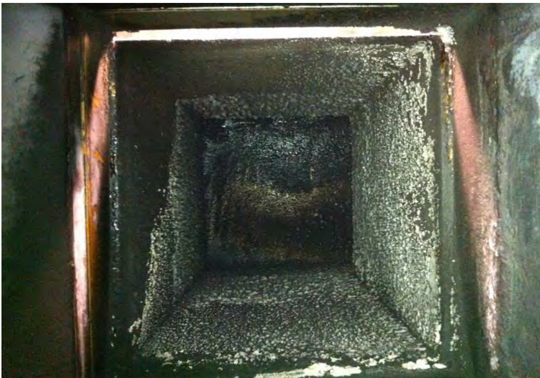
Bild 3. Imkanal ovanför kolgrillen
