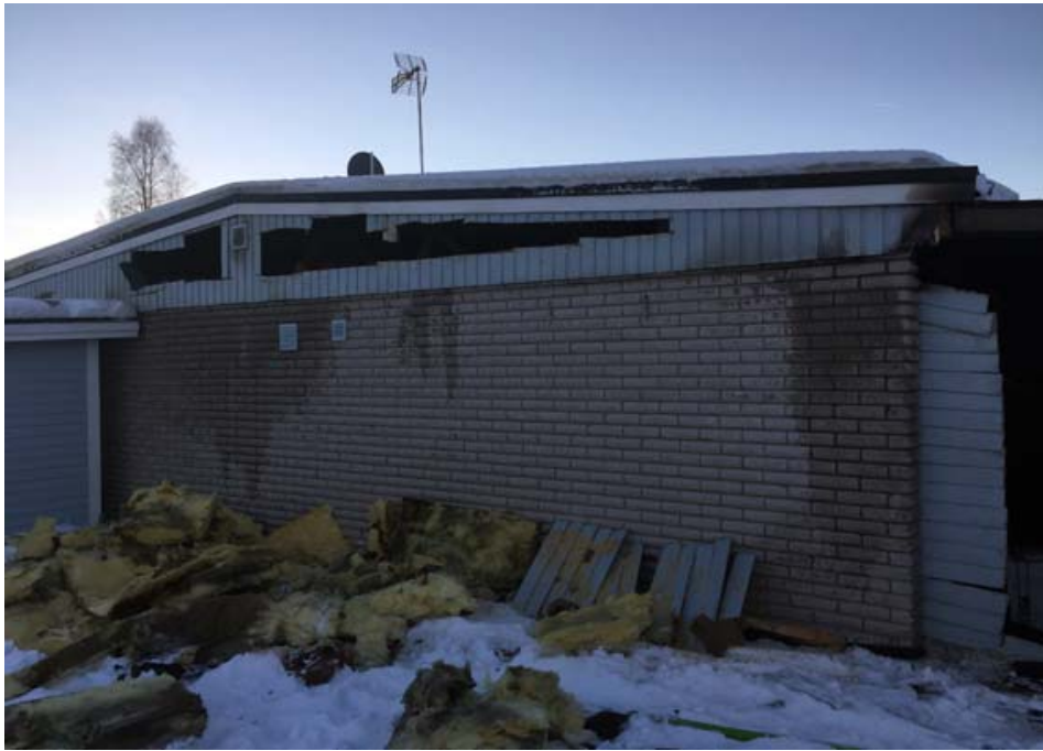
Bild 3. Håltagning i krypvinden på garaget.
