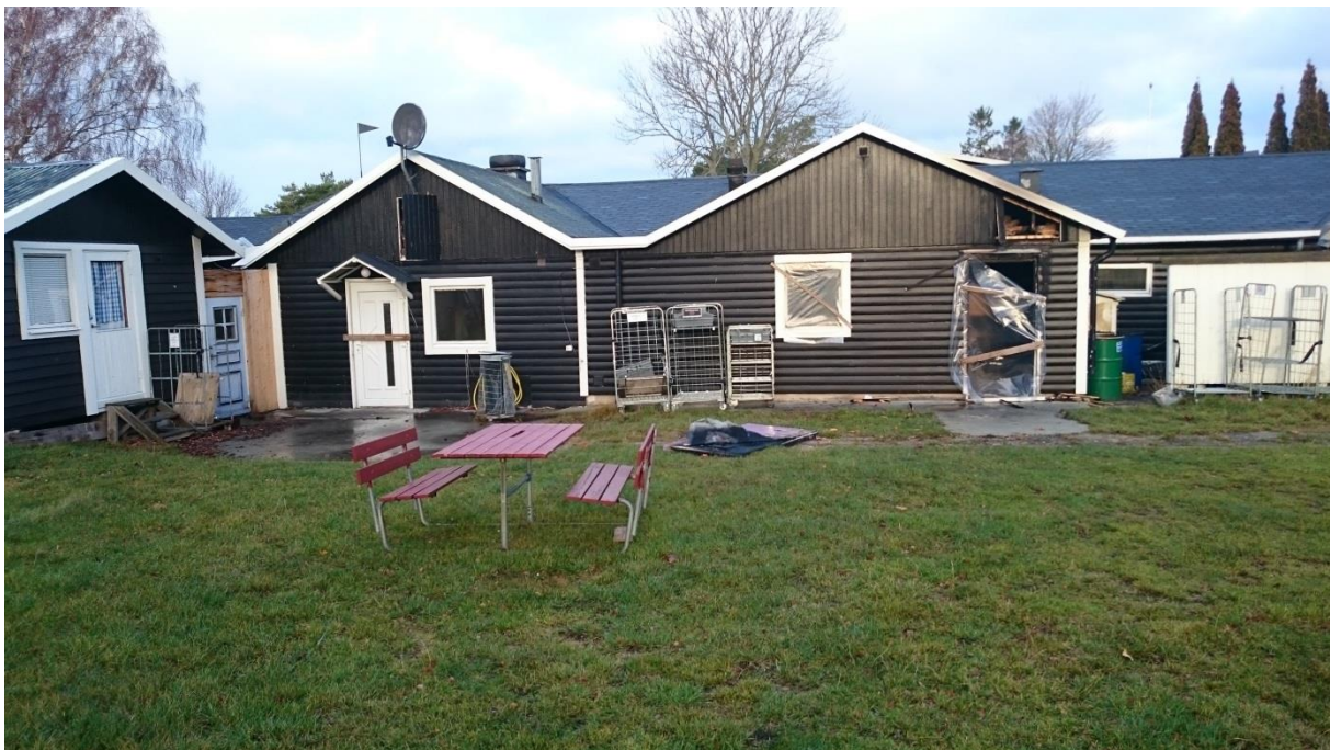
Bild 1. Östra sidan av restaurang Kronan där branden var som intensivast i konstruktionen Bilden är tagen måndagen den 28/12---2015
