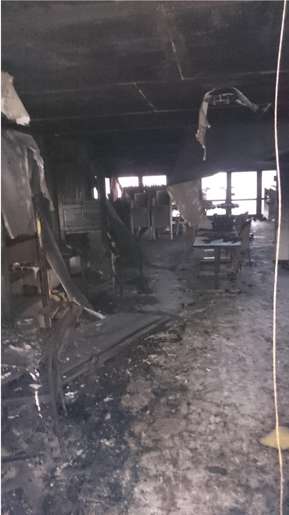
Bild 3. Restaurangdelen där branden inte fått fäste i trädgårdsstolarna . Här har även skumplastdynor antänts vilket har bidragit till hög temperatur på brandgaserna initialt i brandskedet.. Bilden är tagen måndagen den 28/12--2015
