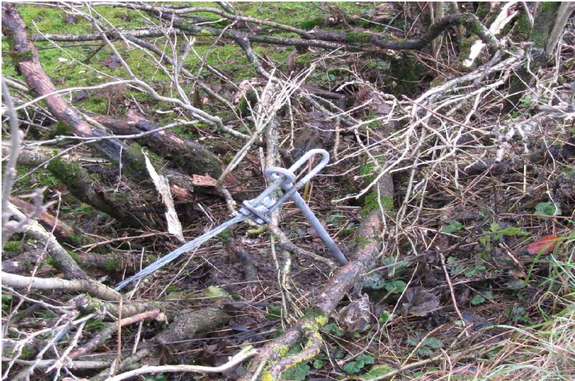
Bild 4: Avkörd stagvajer till telefonstolpe.
