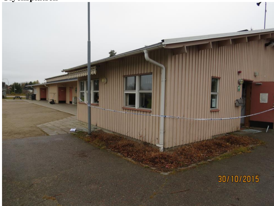
Bild 1. Bilden visar kanslidelen närmast, och omklädningsrum, samt kafédelen i byggnadens fortsättning.
