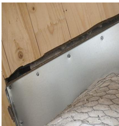
Otätthet mellan ventilationshuv och tak där rök och glöd kom in till vind.
