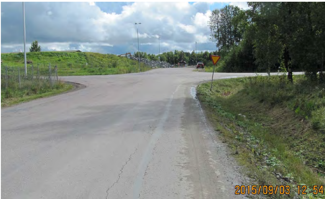
Bild 4: Vy Myrgatan fram mot RV-68. Färdriktning för R
