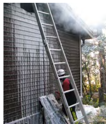
Arbete med att injektera skum i väggen på C-sidan Foto: Räddningstjänsten
