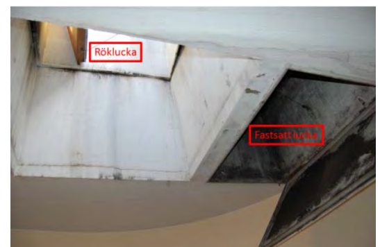
Bild 9. Luckornas placering i trapphuset, sett från brandlägenhetens dörr. Foto: RSG
