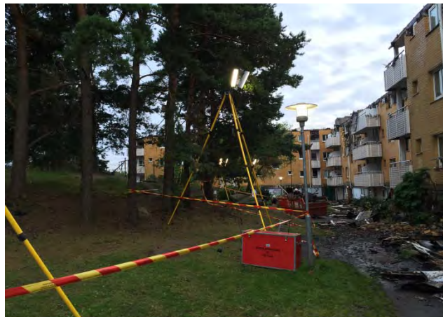
Bild 14. Dagen efter branden. Nedfallna takrester samt avspärning. Källa: RSG
