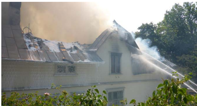
Bild 7. Fortsatt brandspridning nedåt i byggnaden. Utvärdig släckning.
