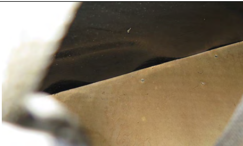
Figur 13 , visar gipsets anslutning mot fuktspärren.
