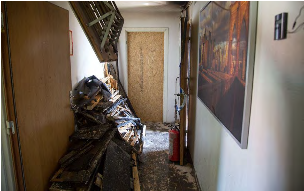
Korridor utanför brandrummet
