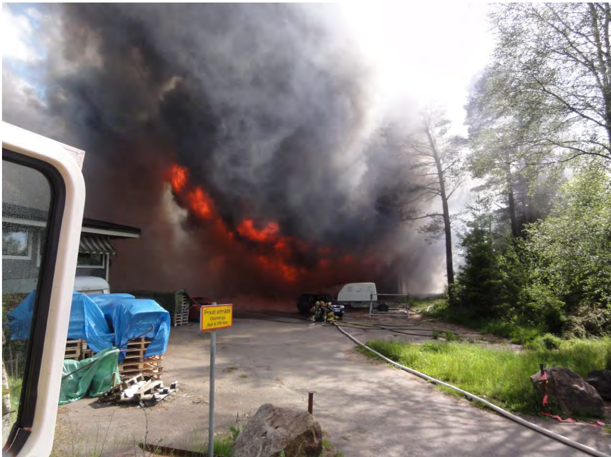
Den brandutsatta industribyggnaden, BIG Stone Garage & Portar, bilden togs i inledning av insatsen. Foto SÄRF.
