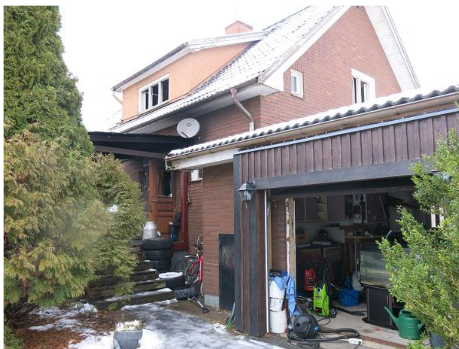
Figur 3: Husets sydöstra gavel och garage efter den första branden (YB:s foto).
