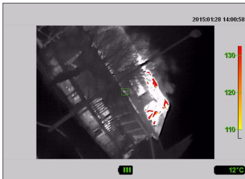
Figur 27: Bild från värmekamera som visar genombränningen av yttertakskonstruktionen ca 1 timme efter återantändning.
