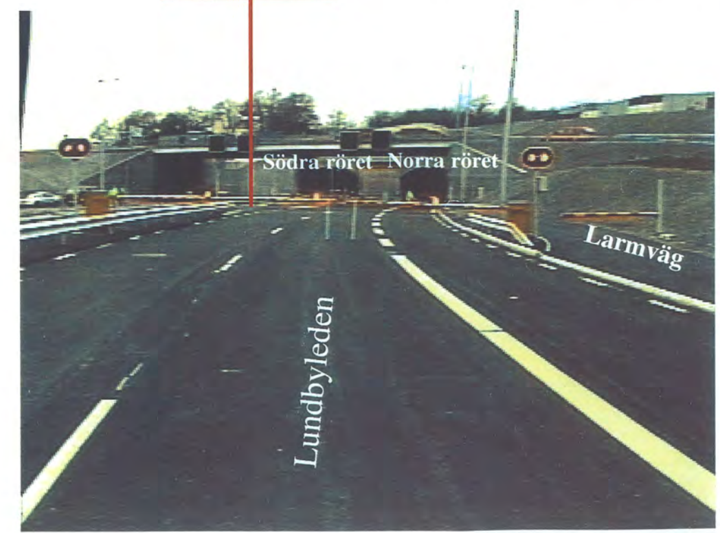
Överfart mellan körbanor Norra och Södra röret
