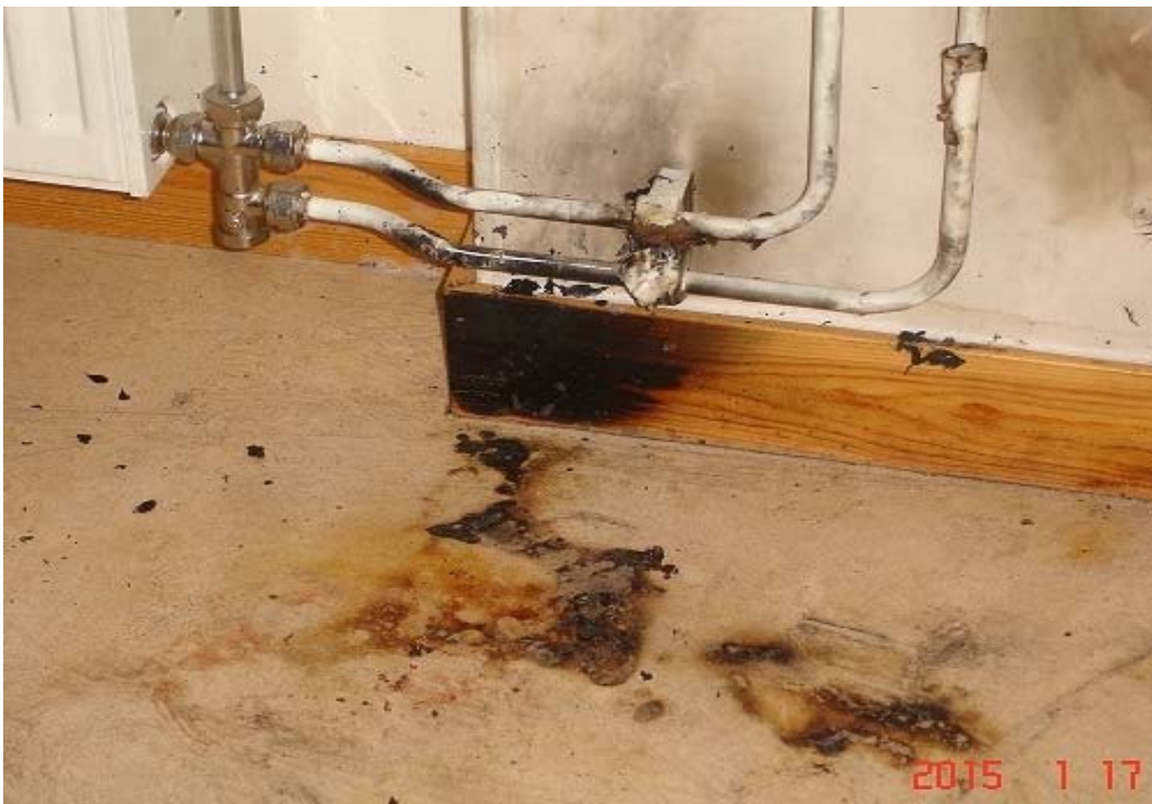
Bild 5: Brandskadad golvsöcket.
