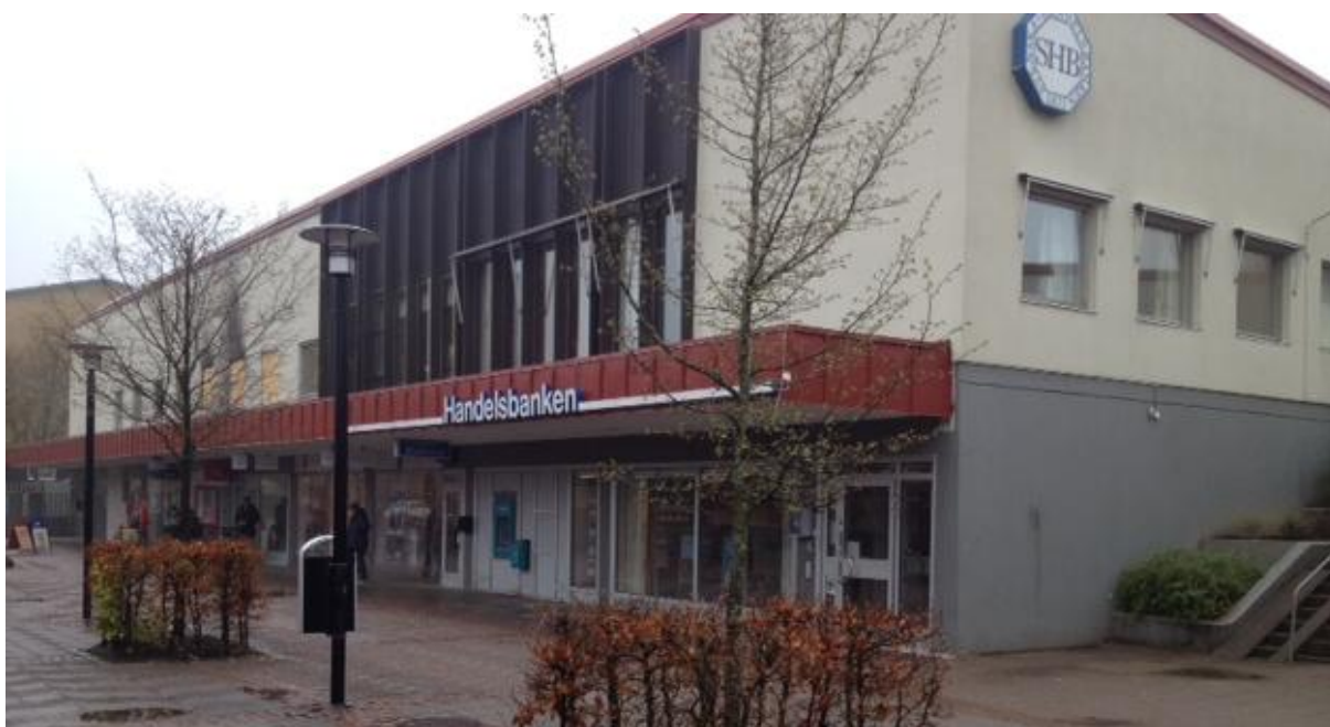
Figur 1. Visar hela byggnaden. Övre plan blev röksmittat ihop med tobaksbutik på nedre plan. Frisör och banklokaler i ytterändar av nedre våning klarade sig från följdskador vid branden.
