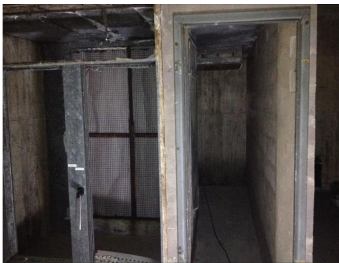
Figur 2. Visar tryckkammare för tilluft.
