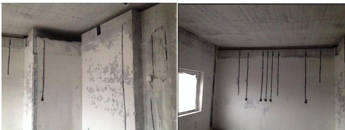
Figur 3 och 4 visar utförande på brandcellsgränser.
