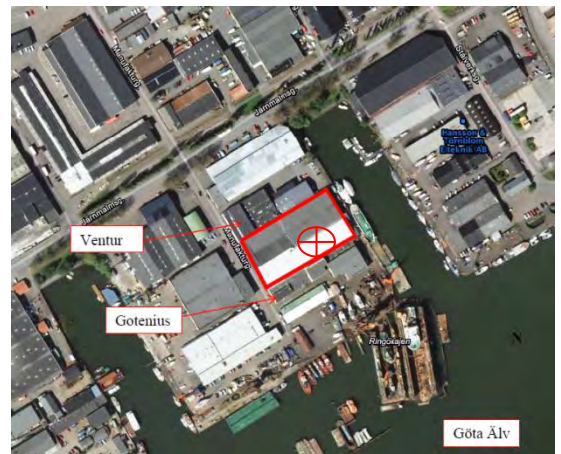
Bild 2. Röd ring med kryss visar var brandröken sågs först enligt vittnesmål. Att detta skulle vara startplatsen på branden går ej att fastställa.
