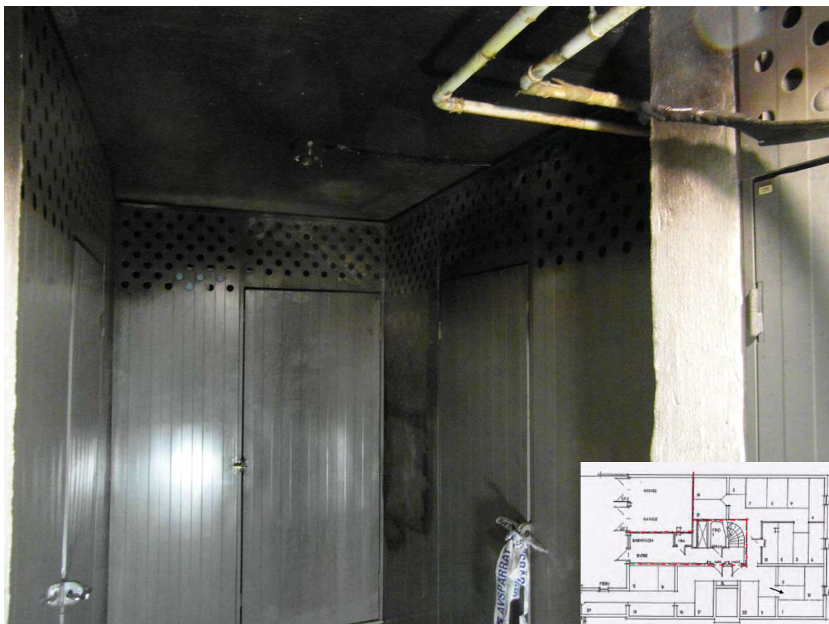
Plåtväggar mot lägenhetsförråd, pilen på miniskissen visar fotoriktning
