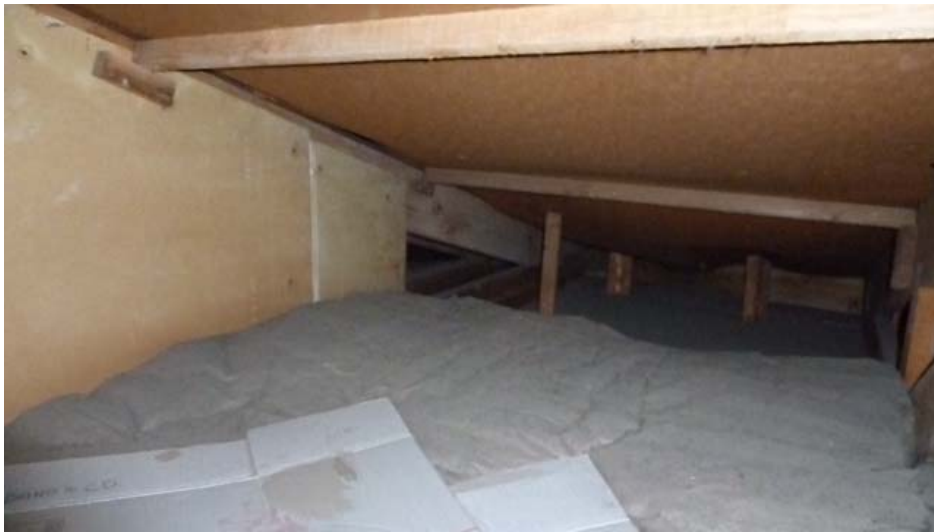
Figur 3 Ej komplett vindssektionering
