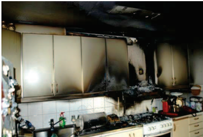
Figur 4, Brandspridningen på och omkring spisen
