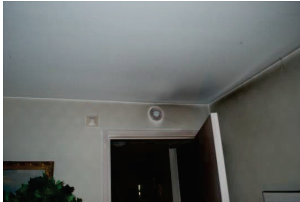
Figur 10, Tilluftsdon i sovrummet, vid dörren som leder ut till hallen. Dörr mot trapphuset finns direkt till höger i hallen
