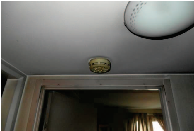
Figur 6, Brandvarnaren, som var placerad precis innanför ytterdörren (till vänster)
