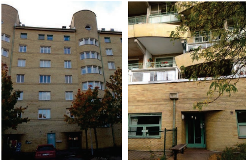
Figur 15,16 Fastigheten från framsidan respektive baksidan (brand på våning 2)
