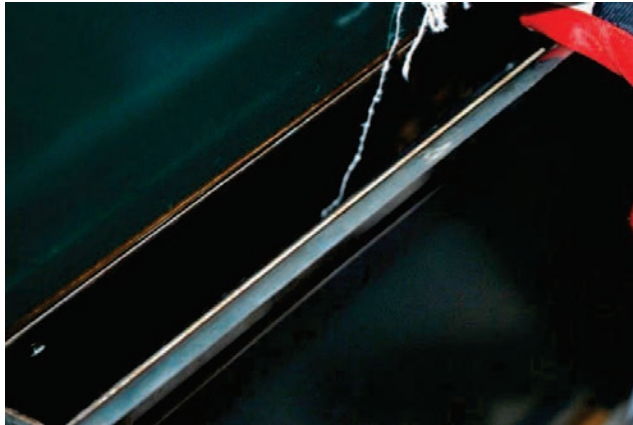
Figur 11, Brevinkastet där undertryck respektive övertryck kan kontrolleras (med en tunn tråd i detta fall)
