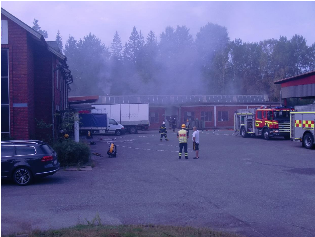
Produktionslokalen mitt i bild och kontorsdelen och lagerdelen till vänster
