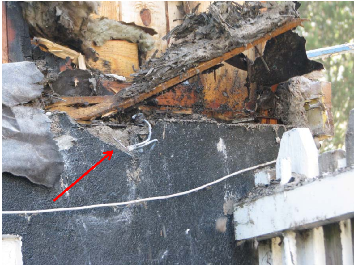
Bild 2 Kabelände som återfanns i vägg
