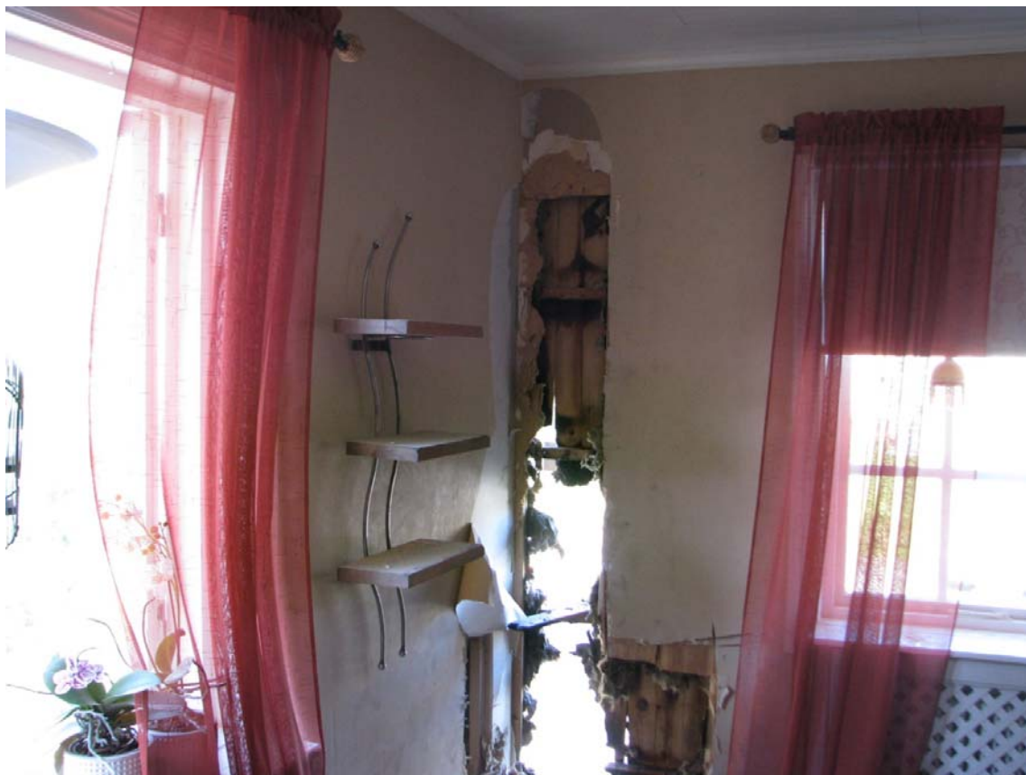
Bild 5 Väggen sedd inifrån
