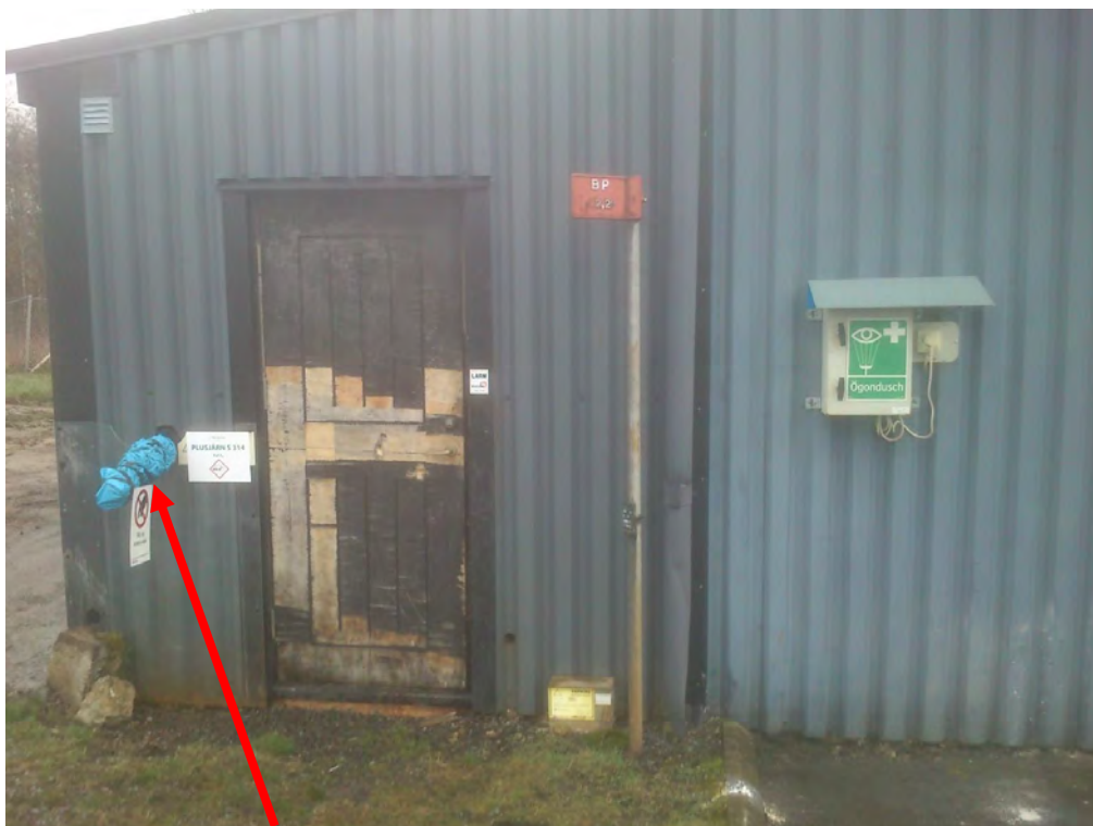
Bild 1: Visar lossningspunkten för järnklorid.
