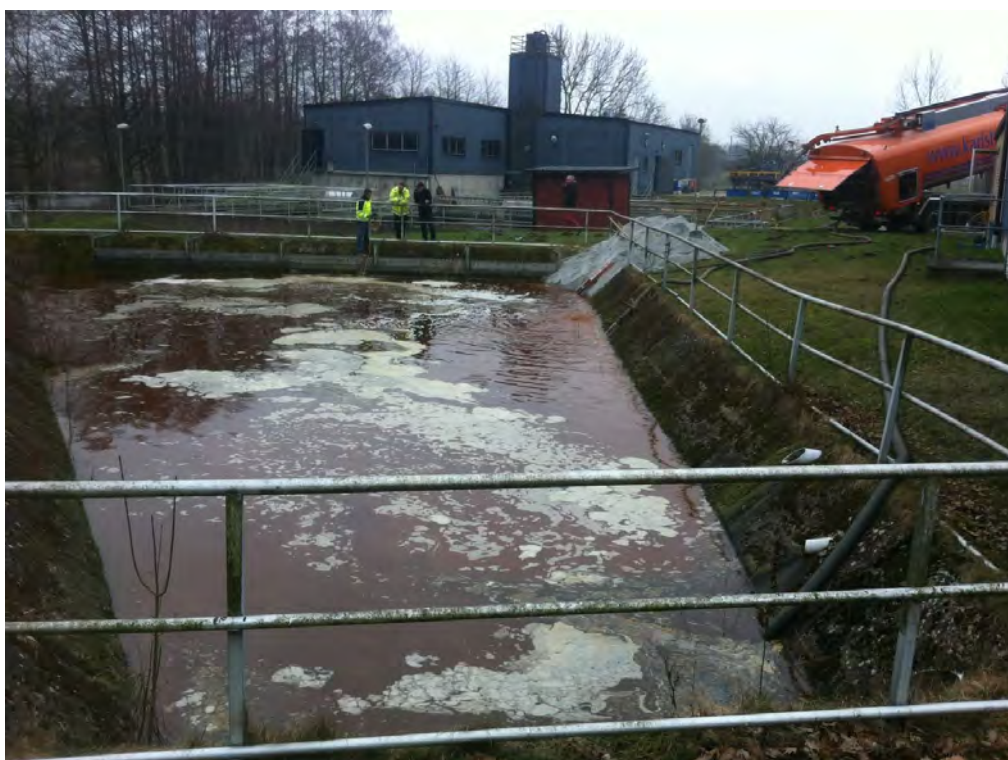
Bild 8: Här kan man se var gruset tippades för att täppa till kommunikationen mellan inkommande pumpsump och utjämningsmagasinet.
