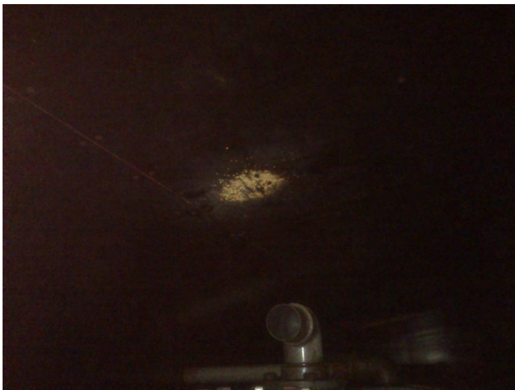
Bild 6: Visar taket ovanför påfyllningsröret och flänslocket, man kan se att takbeklädnaden är angripen av den frätande miljön i cisternrummet.
