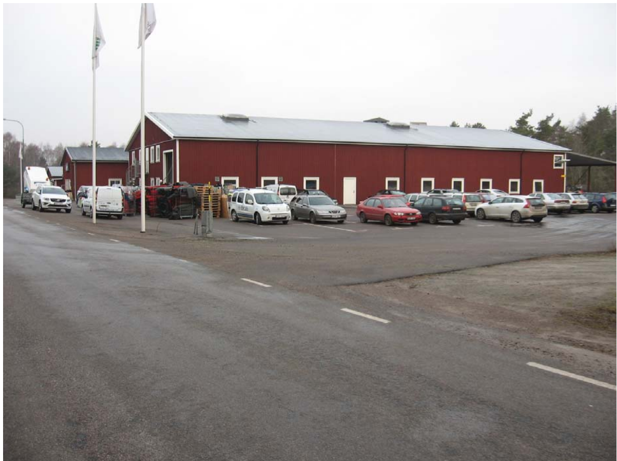
Bild 1. Lindbytvätten, östra delen.
