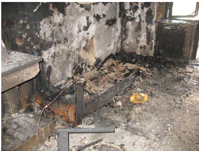
Bild 3. Soffan i den vänstra delen av rummet. I hörnet finns enbart kolrester kvar medan andra delen av soffan är mer intakt.
