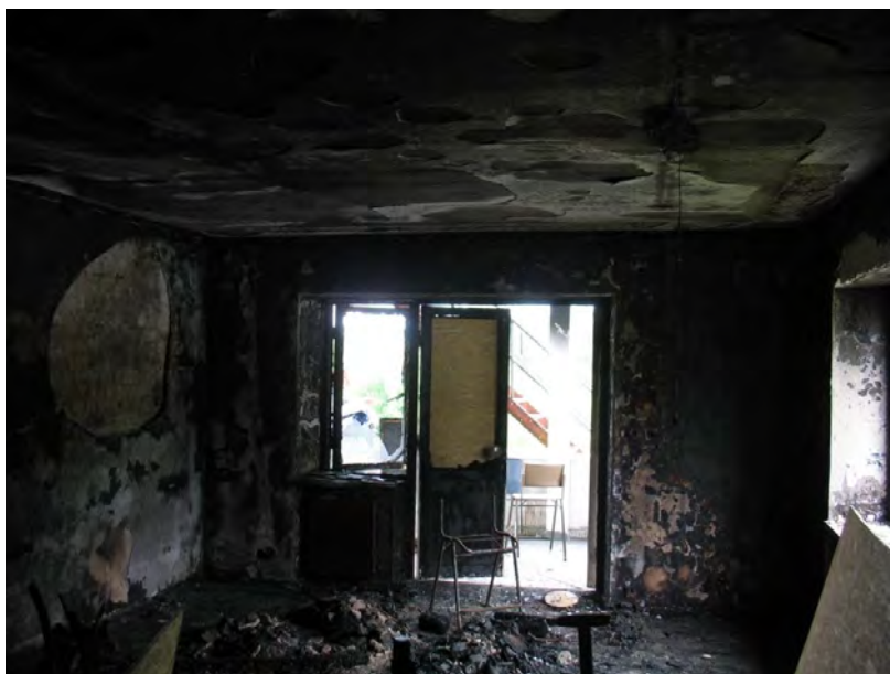
Bild 2. Den del av uppehållsrummet där branden var koncentrerad, sett från korridoren. Sofforna var placerade i de rensopade områdena till höger och vänster i bilden.
