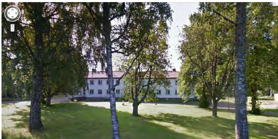
Bild 1. Gatubild av byggnaden (Google maps)
