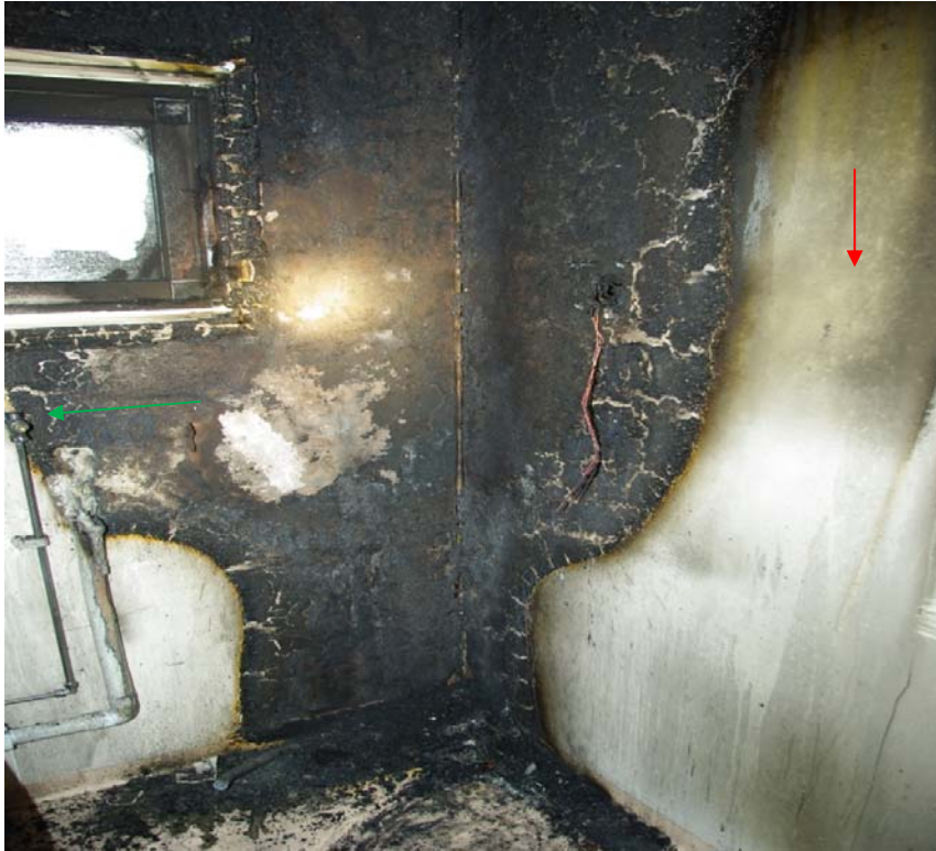
Brandplatsen sett framifrån: Röd pil: elanslutning till maskinen, Grön pil: vatten anslutning
