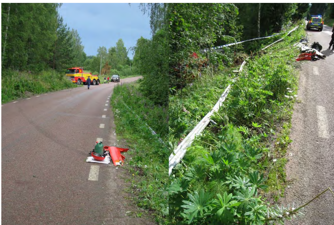
Figur 7 – T.v. Spår som visar brandbilens färd över vägbanan och in i räcket, fotograferat mot färdriktningen. T.h. Vägrräcket och slänten fotograferat i färdriktningen.
