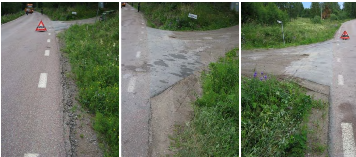
Figur 5 – Från vänster: 1. Avåkningsplatsen, bild på stödremsan tagen i färdriktningen. 2. Vägövergången Sjölidsvägen fotograferad i färdriktningen. 3. Vägövergången fotograferad mot färdriktningen.
