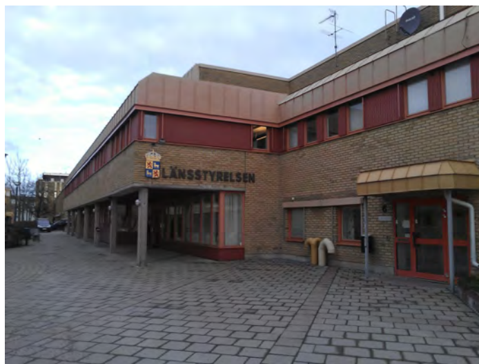
Bild 11. Under Länsstyrelsens lokaler i Kalmar ligger ledningsplatsen Valborg.
