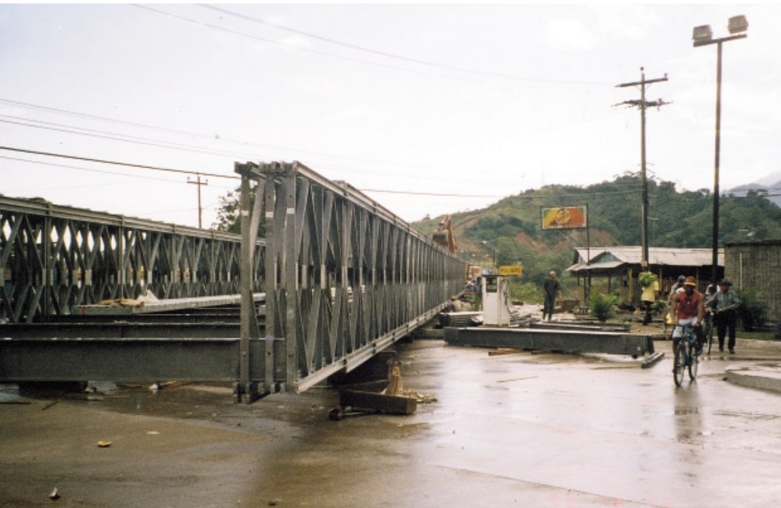
1999, året efter orkanen Mitchs härjningar i Centralamerika, fick Räddningsverket i uppdrag att bygga broar i Honduras (bilden) och Guatemala.
