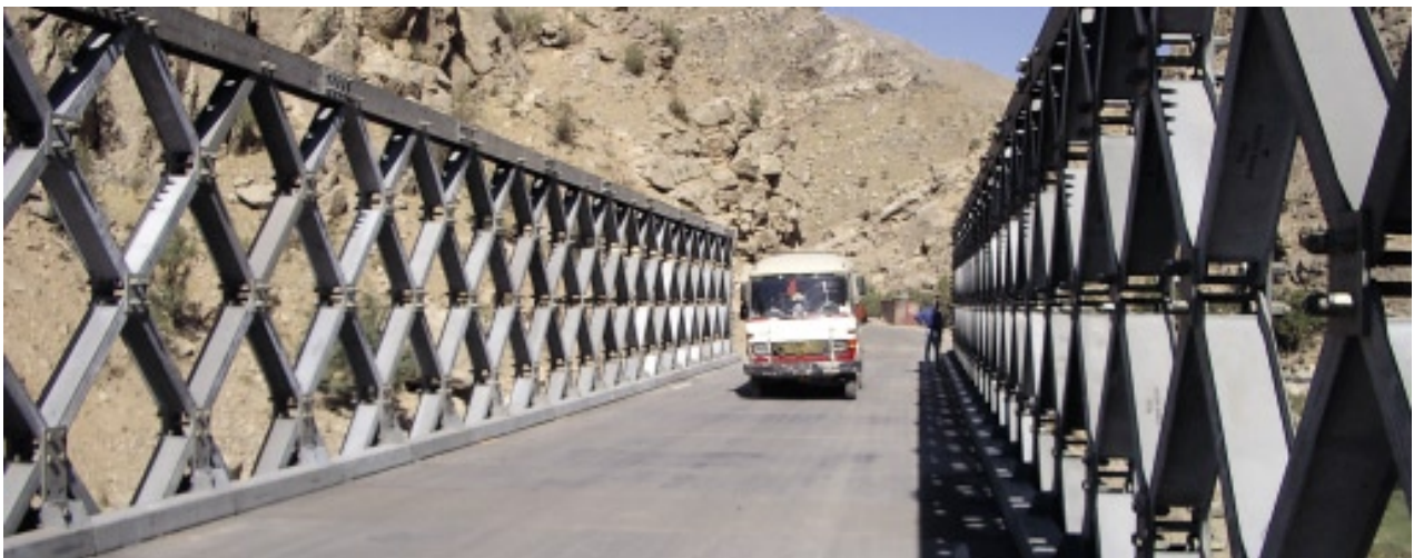
På tre månader byggdes tre broar mellan Kabul och den uzbekiska gränsen.
