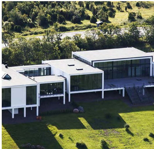
figur 4 Exempel på ett flackt tak
