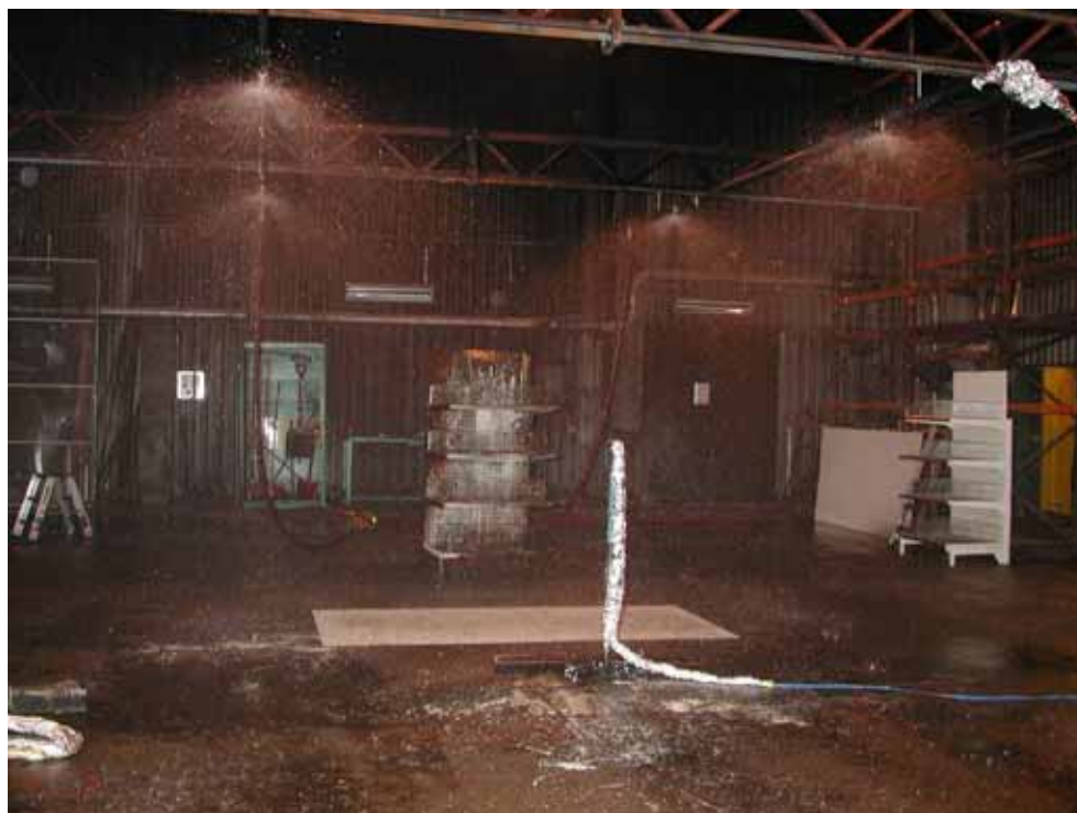
Figur 34 Provkörning av de fyra sprinklerna inför testserie 3. Sprinklerna hängde fritt i brandhallen och aktiverades vid en viss brandeffektutveckling.
