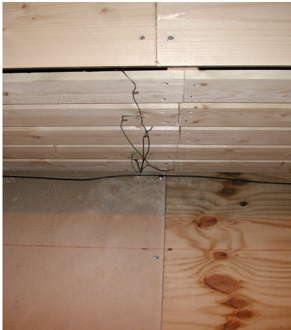
Figur 17. Takfot klädd med glespanel
