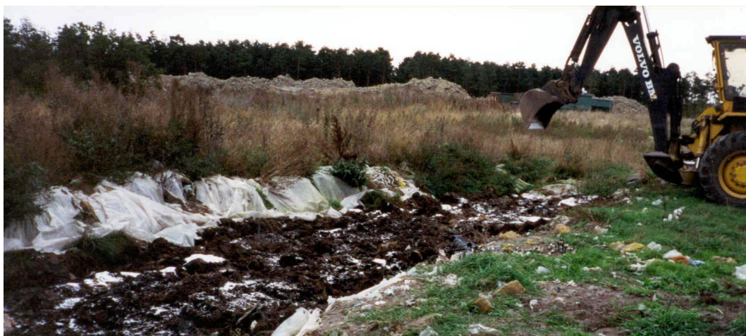
Kompostering av oljehaltigt strandmaterial
