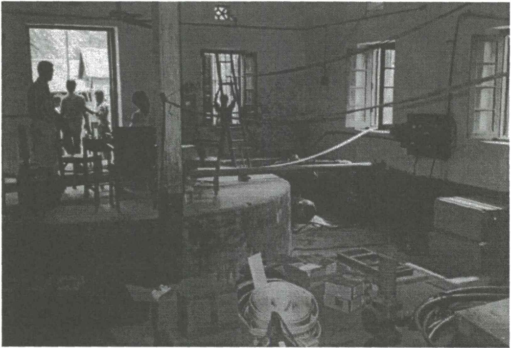
Den befintliga gamla vattenstationen i Sonakanda.
