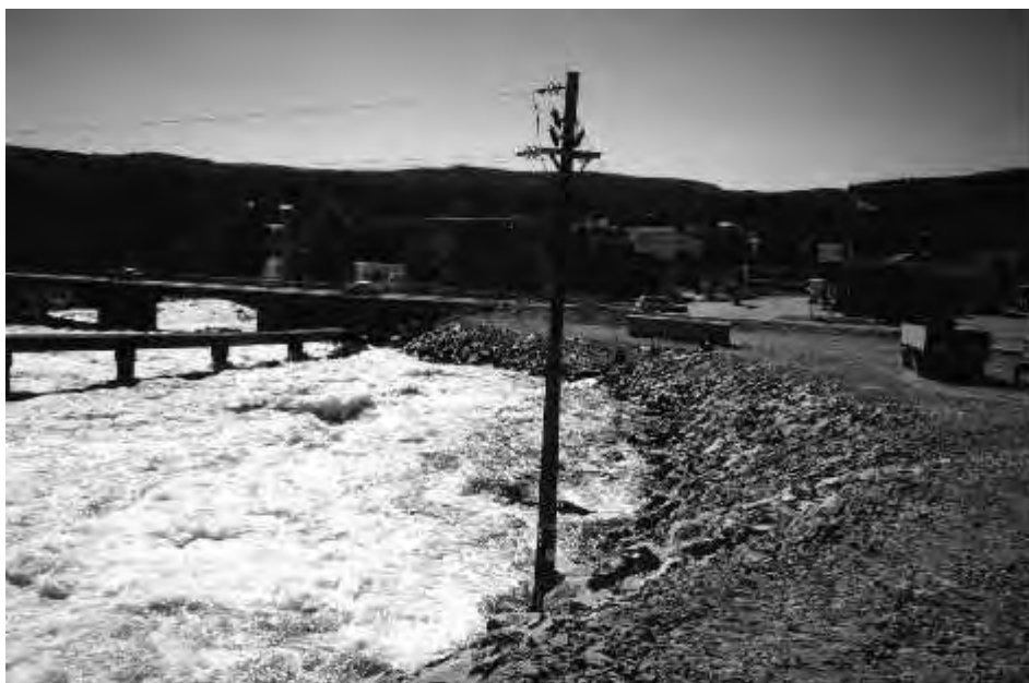
Miljön påverkas av översvämningar som i Torpshammar år 2000. Tomten spolades bort av Gimån och ett hus från sekelskiftet brändes. Den ursprungliga marken, med eventuella föroreningar, är ersatt med stenfyllning och områdets utseende är helt nytt
