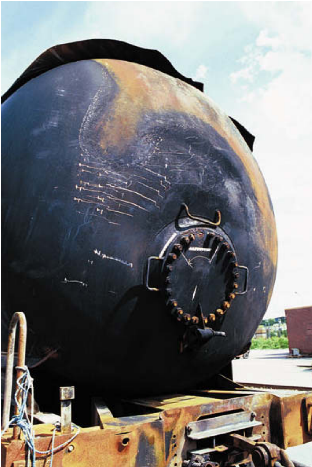
Figur 6.1 Mannhull for inspeksjon Kilde: DnV
