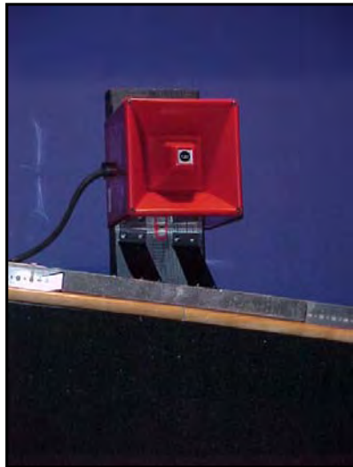
Figur 21. Röd siren med fästansordning.
