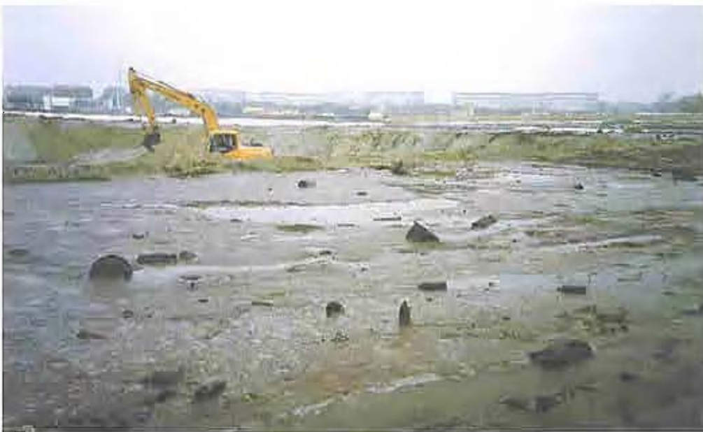
Deponi vid raffinaderiet Elfs anläggning i Donge. Deponierna byggdes upp på tät grund med en vattenpenetration på 15 cm/100 år. Täta vallar byggs upp med sand, kolaska och plastliner. Lakvatten leds till sedimentering och renas om så är nödvändigt innan det släpps vidare till recipient.
