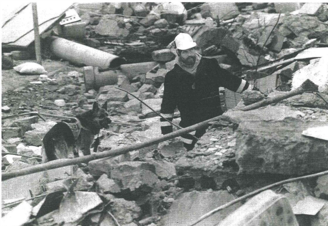
Foto: Stig Dahlé, Räddningsverket
