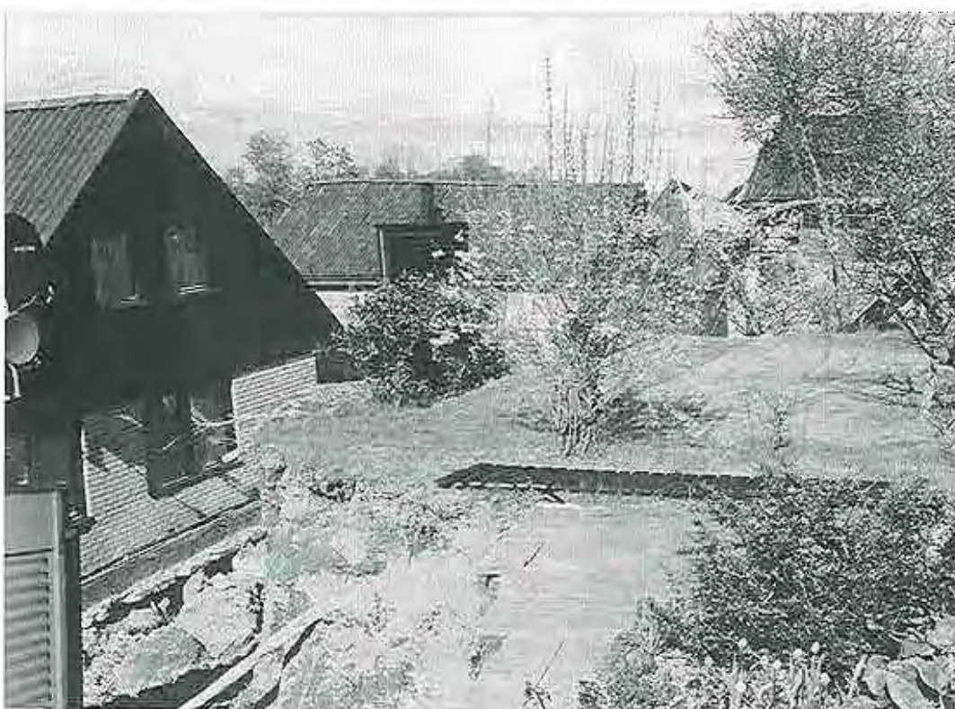
Bild 3. Del av skredet, sett från Påskvägen 10. Foto: Magnus Lindström
